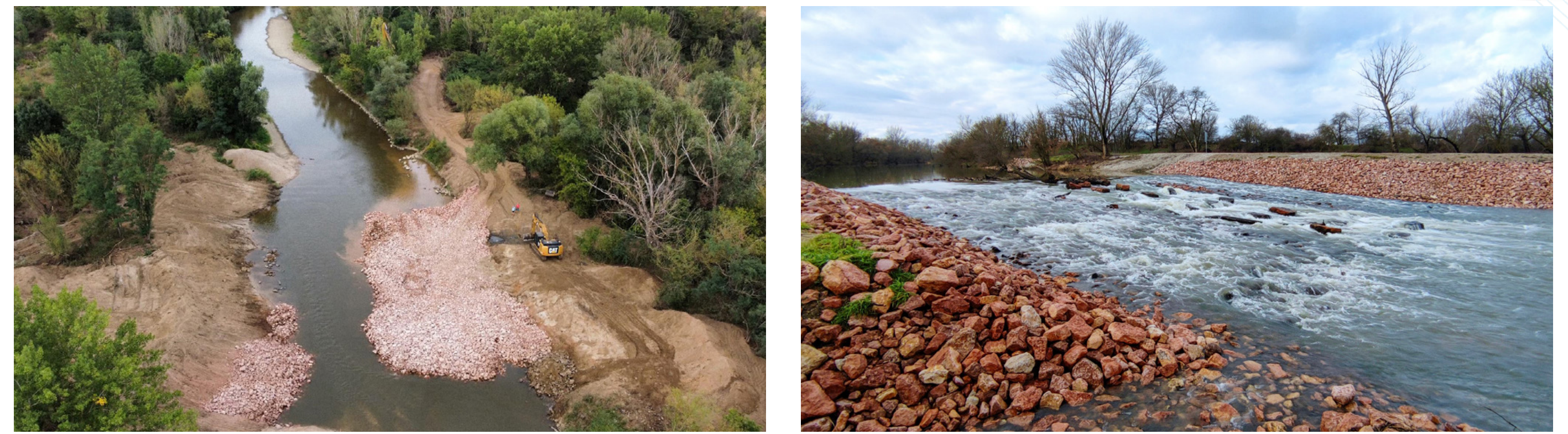
Pápoci fenékküszöb építés közben és a megvalósítást követően
