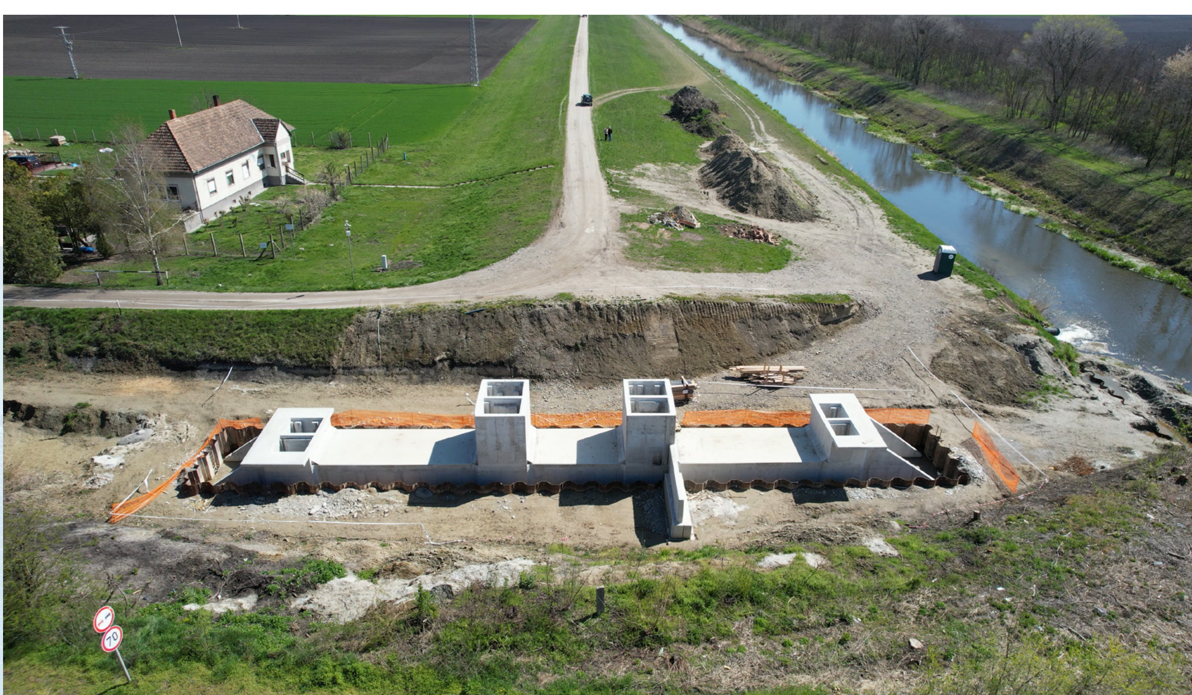
Mosonszentjánosi zsilip vasbeton szerkezetének építése
