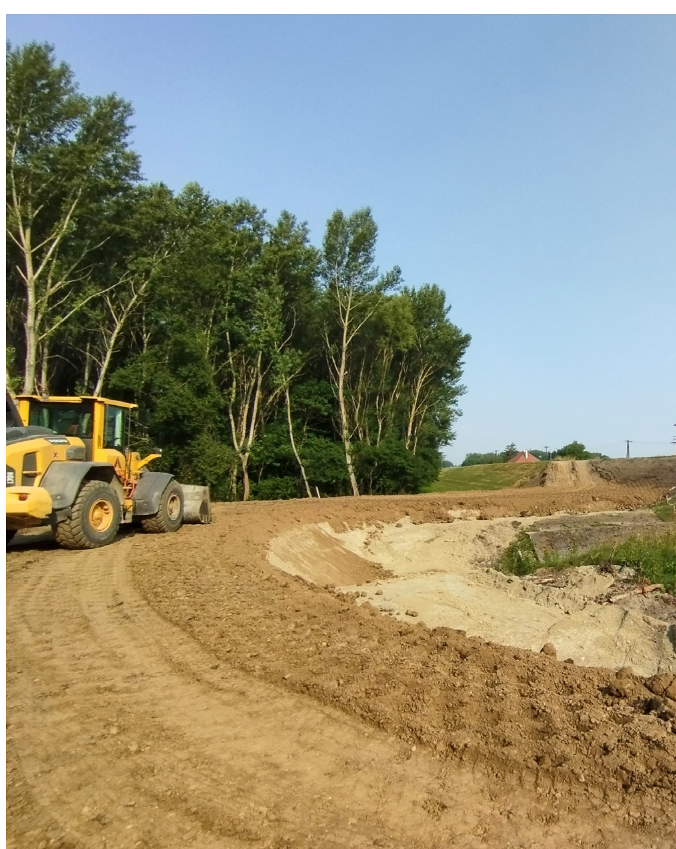
Az ideiglenes körtöltés kialakítása és a víz alatti beton készítése a Börcsi zsilipnél
