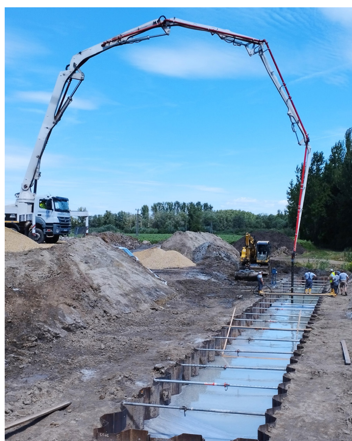
Az ideiglenes körtöltés kialakítása és a víz alatti beton készítése a Börcsi zsilipnél
