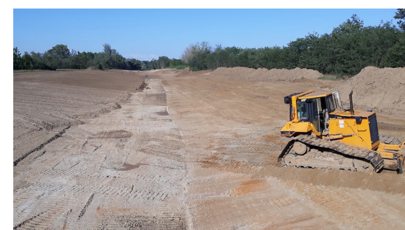
Árapasztó vágó építés közbeni állapota
