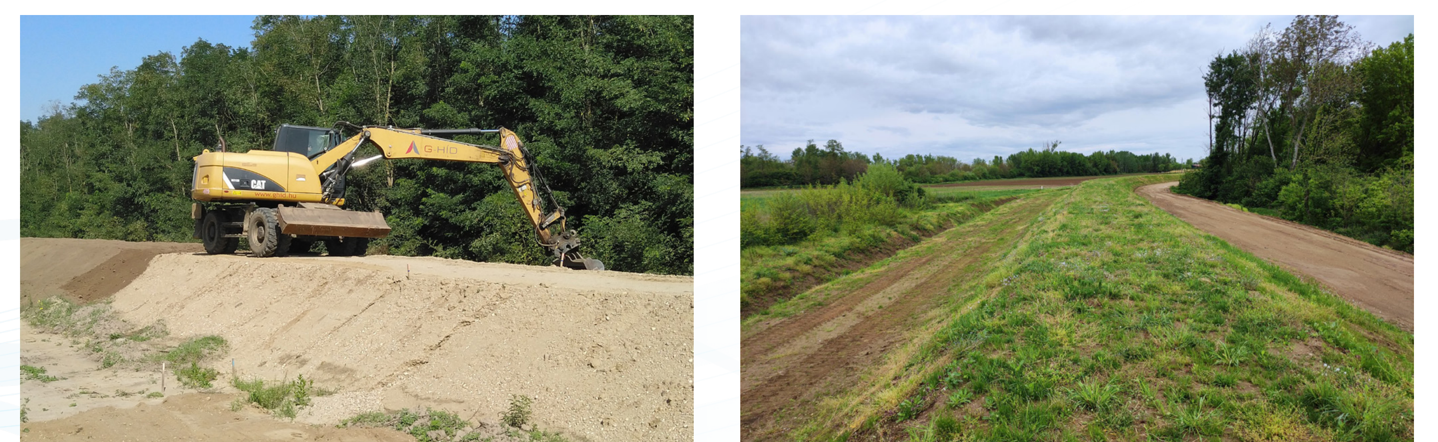
Települési másodrendű védvonal építés közben és a megvalósulás után
