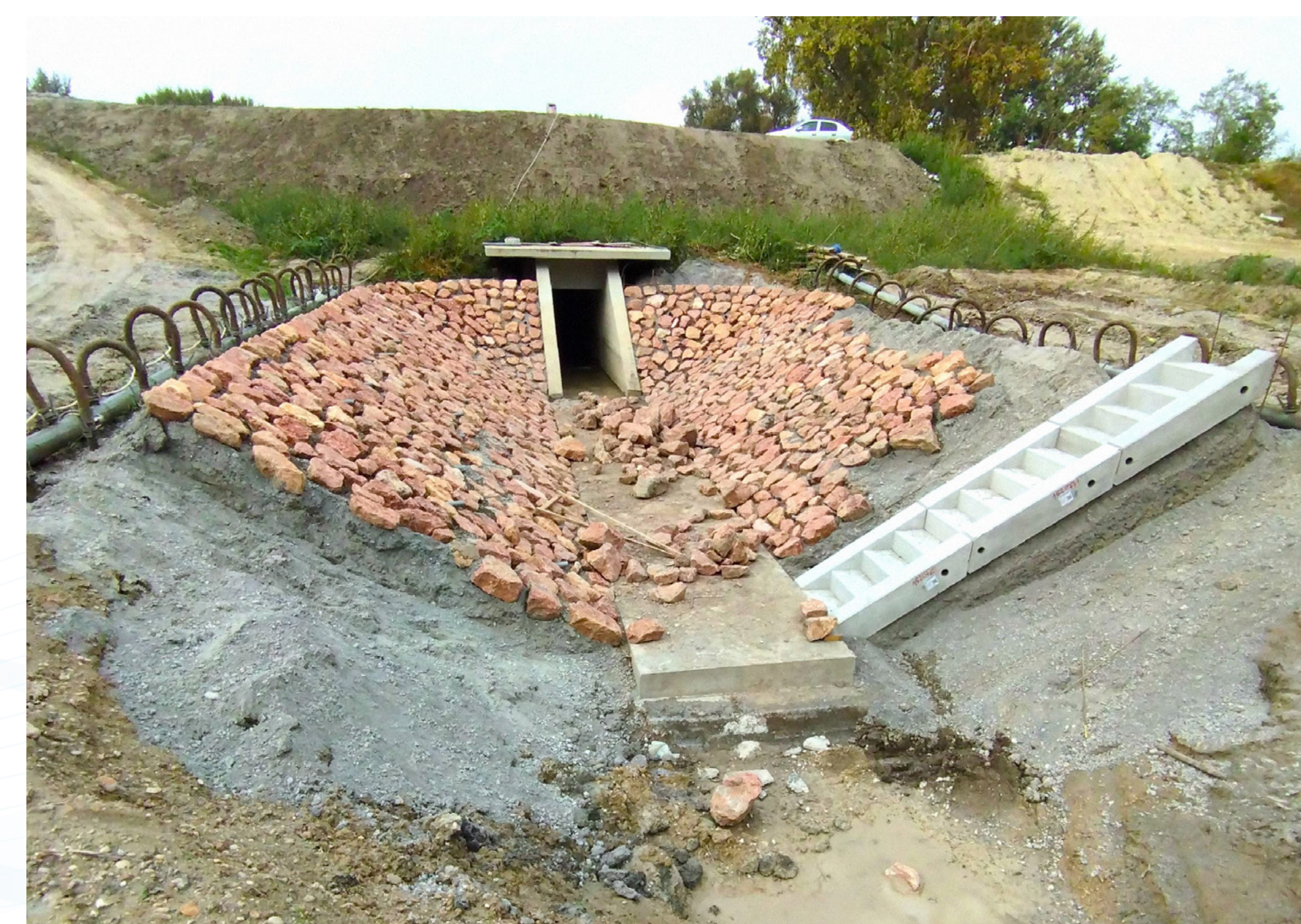
Mederburkolat kialakítása vákuumkutas víztelenítéssel
